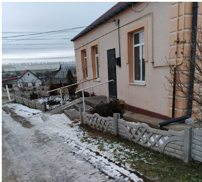
Вхід до МТП, облаштований пандусом (с. Старі Шомполи)
