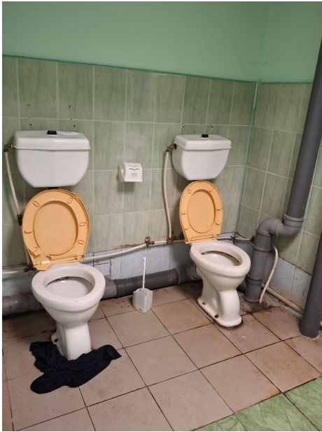
Санвузол в оселі стаціонарного догляду (с-ще Захарівка)
