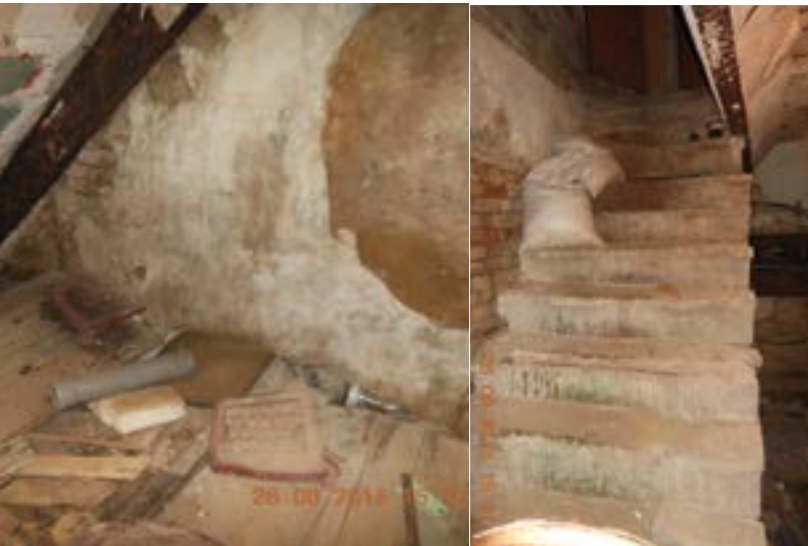
Фото 1-2. Підвальне приміщення Костянтинівської міської ради (Донецька обл., м. Костянтинівка, вул. Леніна, 260).
