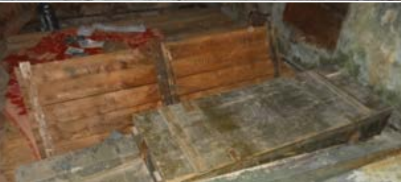
Фото 11-14. Бомбоубежище на территории ЗАО «Лисичанский стеклозавод «Пролетарий», который расположен по адресу: г. Лисичанск, ул. Мичурина, 1.
